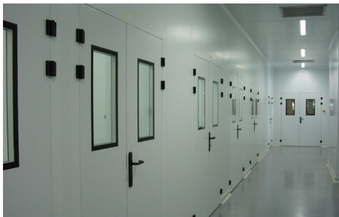
Renovação do Piso 1 do Ed. 15
